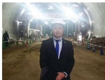
令和3年の暫定供用開始に向けて建設が進む読売ランド線トンネル工事を視察
